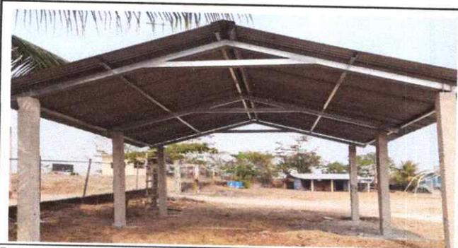
Foto 5: colocación de estructura de galera
