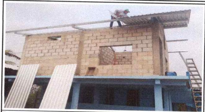
Foto 2: estructura y colocación de lámina
