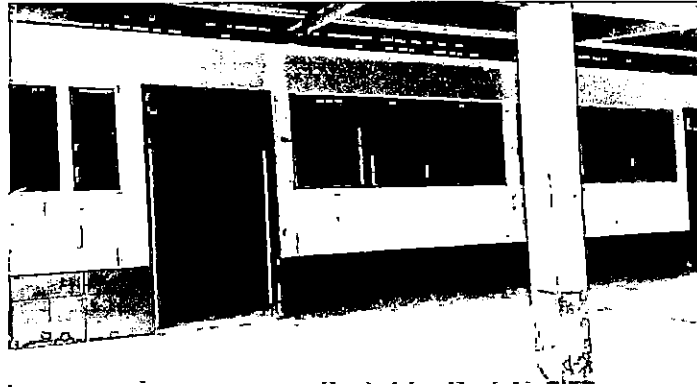
FOTO 1: SUSTITUCION DE VENTANAS Y BÁLCONES
