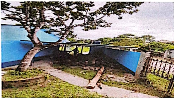
Foto1: Reparación de muro perimetral de block.
