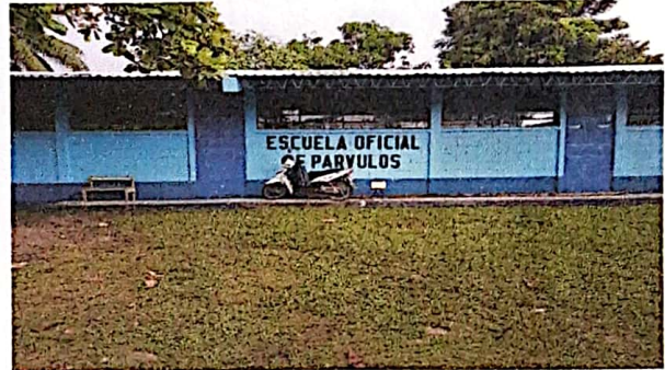
Foto 2: Sustitución de lámina por laminá troquelada calibre 26
