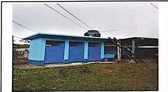
Foto 2: Sustitución de puertas en servicios sanitarios.
