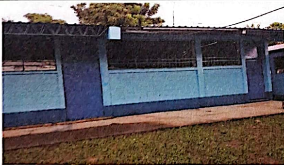
Foto 5: Sustitución de puerta y sustitución de chiapa.
