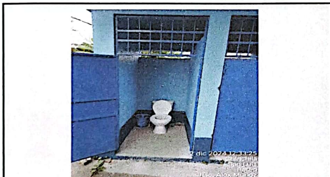
Foto 3: Sustitución de servicios de sanitarios.
