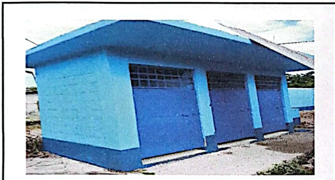
Foto1: Sustitución de servicios sanitarios.
