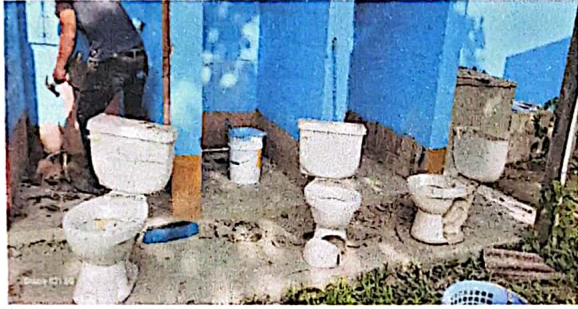
Foto 1: Sustrucción de servicios sanitarios.
