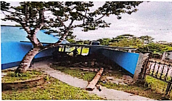
Foto 1: Reparación de muro perimetral de block.
