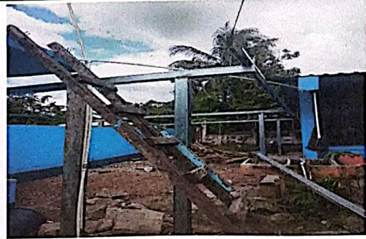
Foto 2: Sustitución de lámina por laminá troquelada calibre 26
