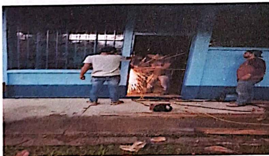
Foto 5: Sustitución de puerta y sustitución de chiapa.
