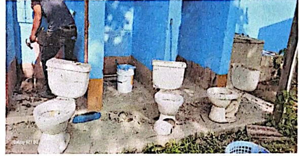
Foto 2: Sustrucción de puertas en servicios sanitarios.
