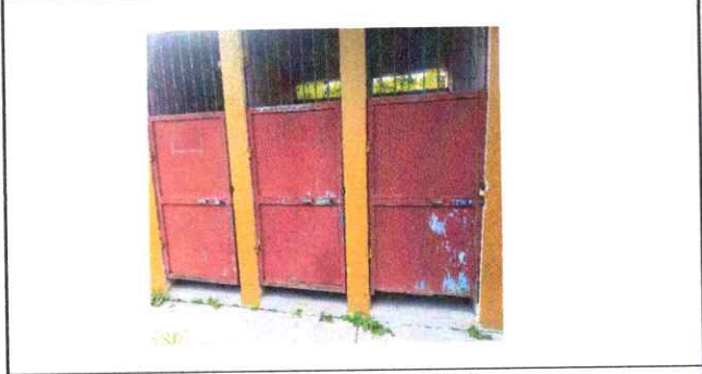
Foto 2: Sustitución de puerta en servicios sanitarios
