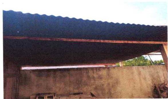
Foto 2: Sustitución de lamina por lamina troquelada claibre 26.
