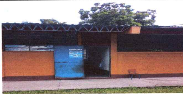
Foto 5: Sustitución de puertas y sustitución de chapa.
