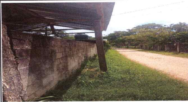
Foto1: Reparación de muro perimetral de block.
