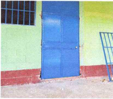
Foto 3: Sustitución de puertas de metal
