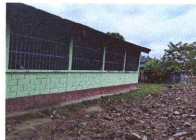
Foto 6: Sustitución de balcones de metal
