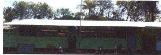
Foto 2: Sustitución de lamina por lamina troquelada calibre 26
