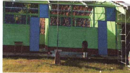
Foto 4: Sustitución de puertas de metal
