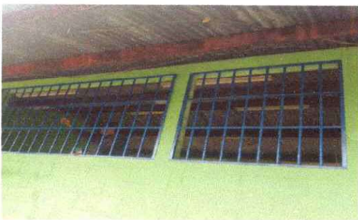
Foto 5: sustitución de balcones de metal
