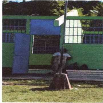
Foto 4: Sustitución de puertas de metal
