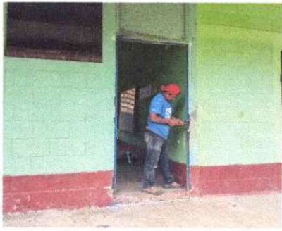
Foto 3: Sustitución de puertas de metal
