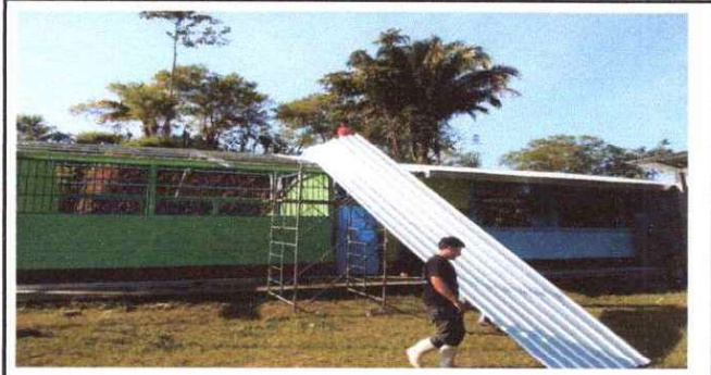
Foto1: Sustitución de lamina por lamina troquelada calibre 26
