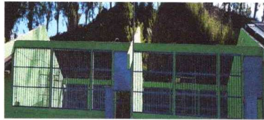
Foto 2: Sustitución de lamina por lamina troquelada calibre 26
