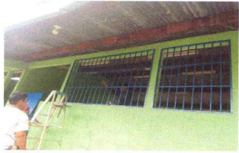
Foto 6: Sustitución de balcones de metal
