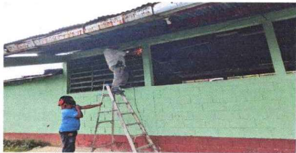
Foto 5: sustitución de balcones de metal
