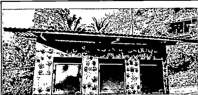
Foto1: Repaclón de sanitarios, techo y puertas.
