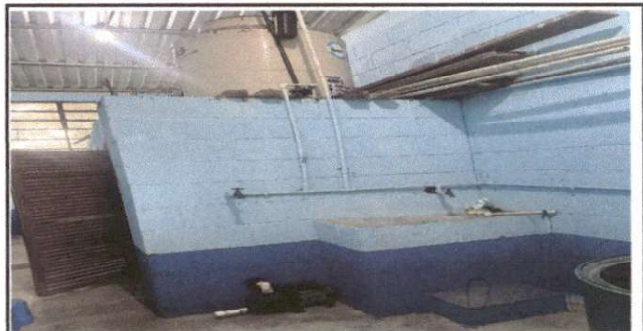
Foto 6: Sustitución de tubería línea principal
