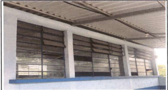
Foto 2: Fabricación e instalación de ventana-balcón de metal
