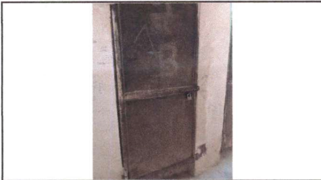
Foto 3: Fabricación e instalación de puertas de metal en baños
