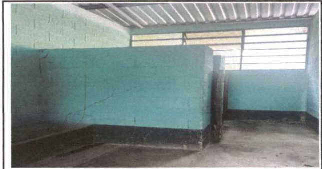
Foto 4: Pintura en muros exteriores e interiores
