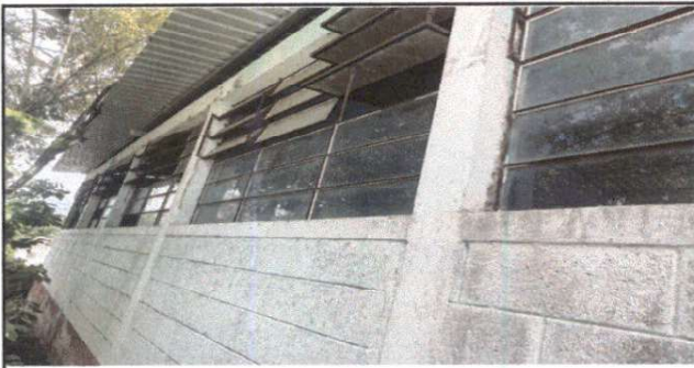
Foto 1: Mantenimiento a balcones de metal
