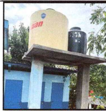
Foto 20: Instalación de depósito de agua de 2,500 lts para baños
