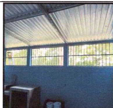
Foto 22: Pintura en interior y exterior de paredes en ampliación de cocina
