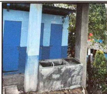
Foto 21: Instalación de pila y 1 lavadero para servicio de baños
