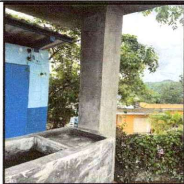
Foto 19: Levantado de columna y terraza para instalación de depósito de agua de 2,500 lts en baños
