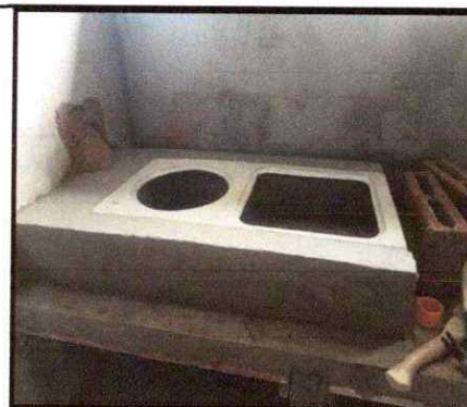
Foto 10: Fabricación e instalación de cocina rural (plancha y chimenea)
