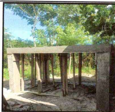
Foto 16: Levantado de columnas y terraza para instalación de depósito de agua de 2,500 lts en cocina
