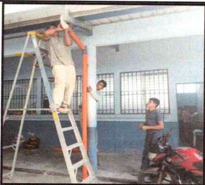
Foto7: Instalación de bajadas de agua pluvial tubo PVC3" en corredor
