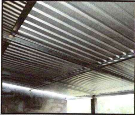
Foto1: Sustitución de lámina por lámina troquelada aluzinc calibre 26 en ampliación de cocina
