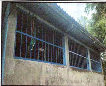
Foto 15: Instalación de balcón de metal en ampliación de cocina
