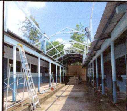
Foto 4: Instalación de estructura portante de metal en corredor
