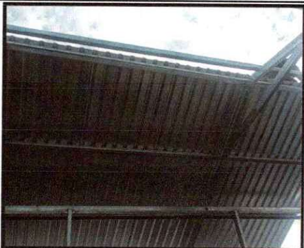
Foto 5: Instalación de lámina troquelada aluzinc calibre 26 en corredor
