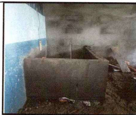
Foto 12: Instalación de pila y 1 lavadero en cocina
