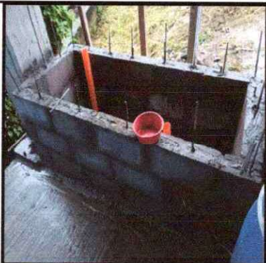
Foto 21: Instalación de pila y 1 lavadero para servicio de baños
