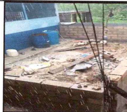
Foto 8: levantado de block en paredes de cocina
