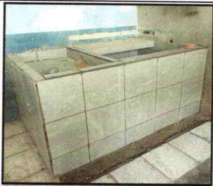
Foto 13: Instalación de azulejo a pila de cocina
