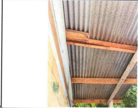
Foto1: Sustitución de lámina por lámina troquelada
