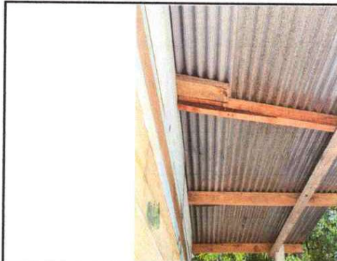
Foto 2: Sustitución de estructura de soporte de madera por metal
