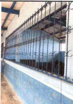
Foto 11: Fabricación e Instalación de Ventana balcón de metal para dirección
