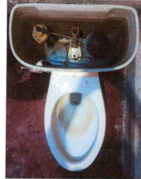
Foto 8: Sustitución de inodoro
