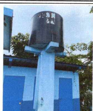
Foto 14: Sustitución de depósitos de Agua
