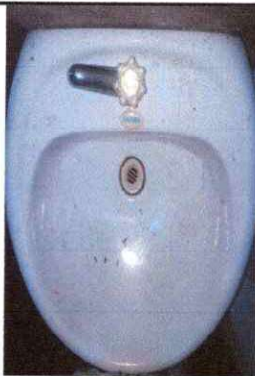
Foto 9: Sustitución de Lavamanos
