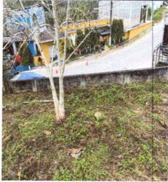
Foto7: Reparación de muro perimetral de block
