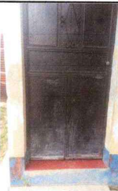
Foto 10: Fabricación e instalación de Puertas de metal en baños
