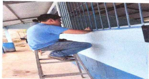
Foto 6: mantenimiento a balcones de metal.
