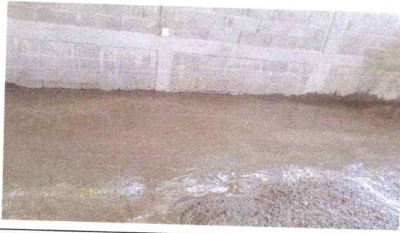
Foto1: Reparación de piso de cemento líquido.
