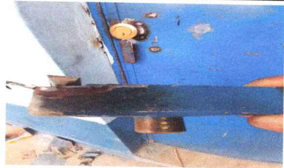
Foto 4: Sustitución de chapa.
