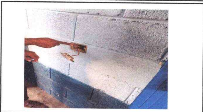
Foto1: Sustitución de tomacorrientes dobles.
