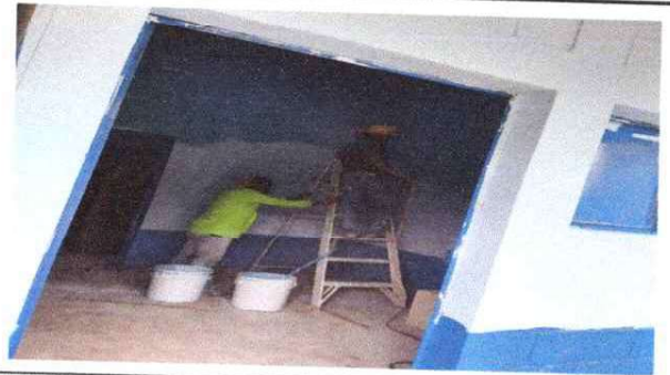
Foto 4: Pintura en muros exteriores e interiores.
