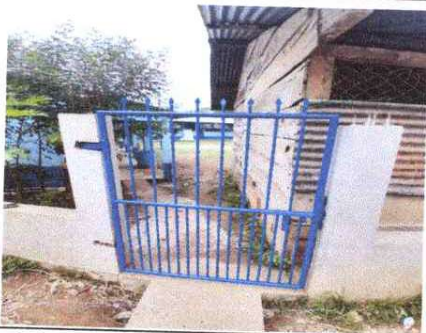
Foto 5: Mantenimiento a porton de metal.
