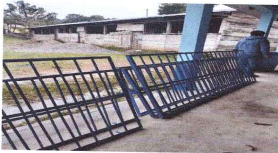
Foto 5: Sustitución de balcon de metal
