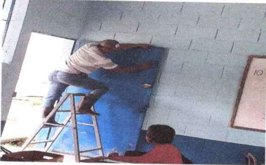
Foto 3: mantenimiento a estructura de puerta
