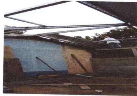
Foto 2: Sustitucion de estructura de soporte de madera por metal.
