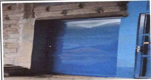
Foto 8: Sustitución de puerta de metal
