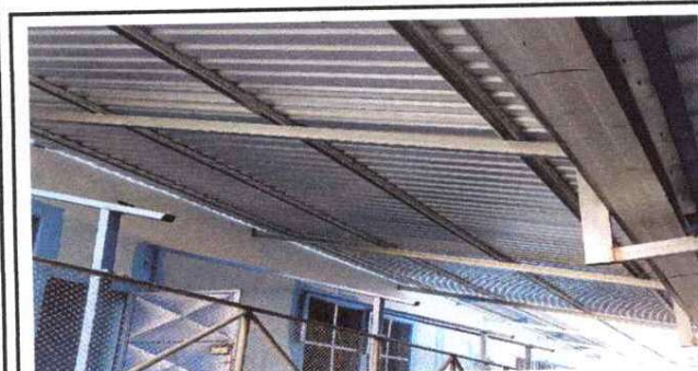
Foto 3: Sustitución de lámina por lámina troquelada aluzinc calibre 26
