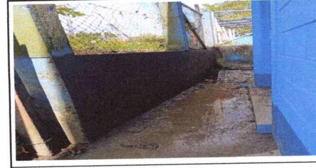
Foto 6: Repello en muros
