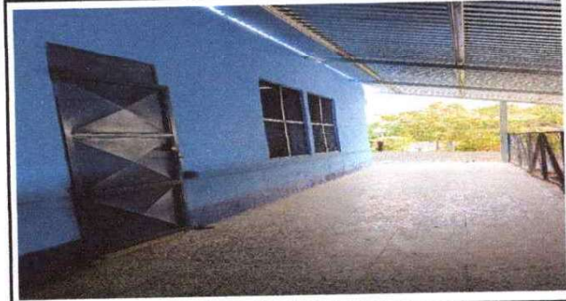
Foto 4: Sustitución de estructura de soporte de metal
