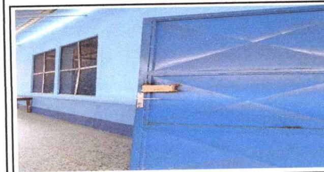
Foto 5: Sustitución de chapas
