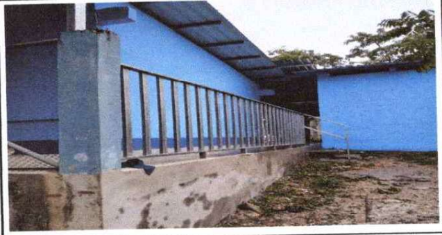
Foto 2: Se instaló barandas de metal
