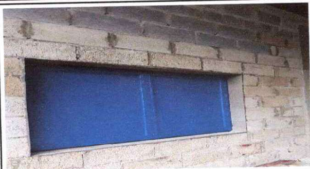
Foto 7: Sustitución de ventana de metal
