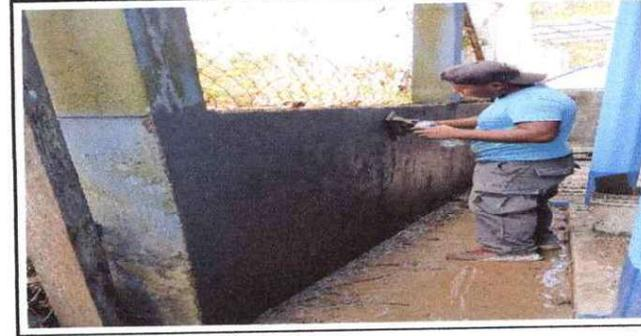
Foto 6: Se realiza el repello en muros
