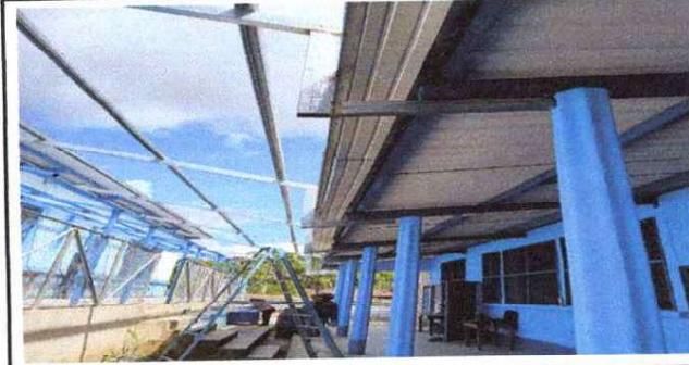
Foto 4: Sustitución de estructura de soporte
