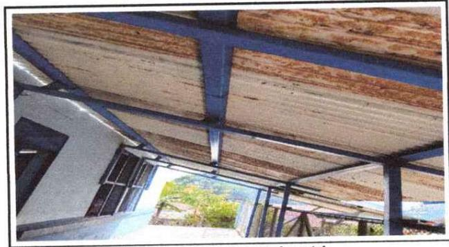
Foto 4: Se sustituirá la estructura de soporte de metal.
