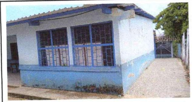
Foto1: Se intervendrá, la pintura de muros de interiores y exteriores de toda la escuela.
