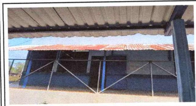
Foto 3: Se sustituirá lámina por lámina troquelada aluzinc calibre 26.
