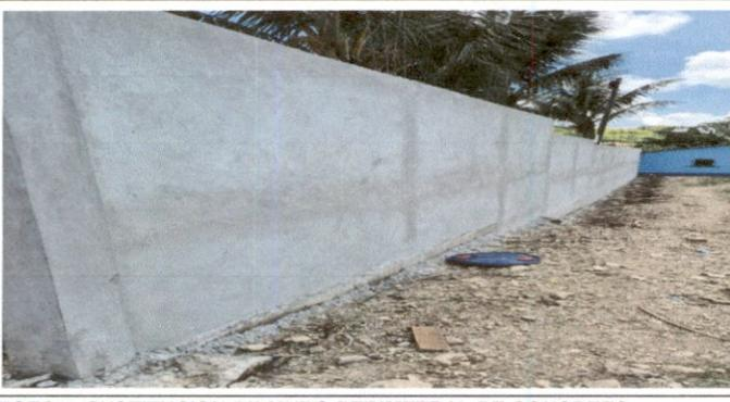
FOTO 5: SUSTITUCION DE MURO PERIMETRAL DE CONCRETO
