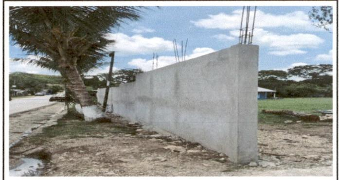
FOTO 4: SUSTITUCION DE MURO PERIMETRAL DE CONCRETO
