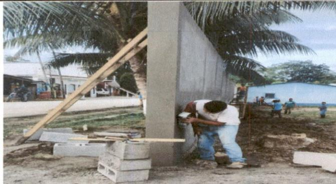
FOTO 1: SUSTITUCION DE MURO PERIMETRAL DE CONCRETO
