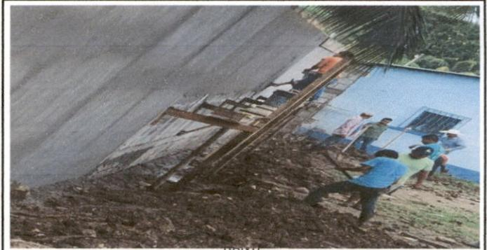
FOTO 6: SUSTITUCION DE MURO PERIMETRAL DE CONCRETO
