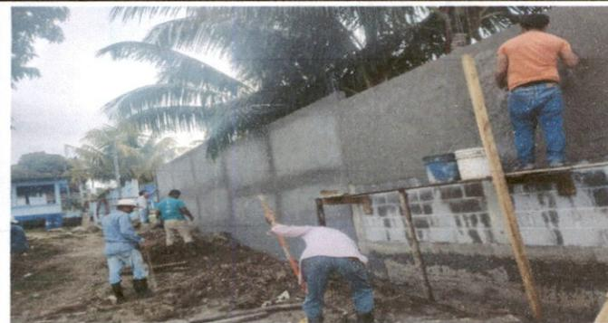
FOTO 5: SUSTITUCION DE MURO PERIMETRAL DE CONCRETO
