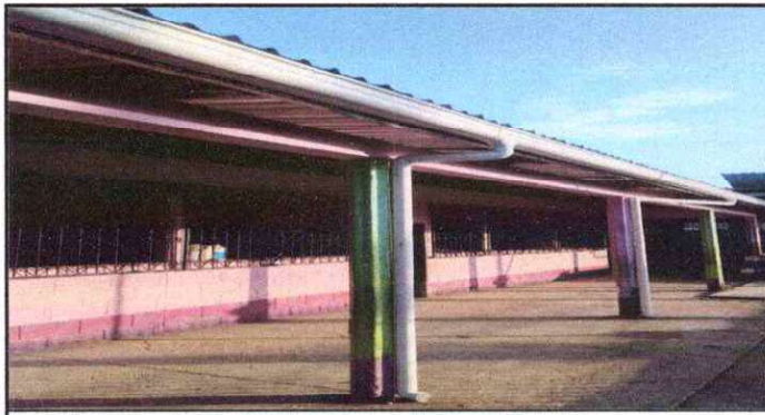
Foto 5: Reparación de bajada de agua pluvial, tubo PVC 3"
