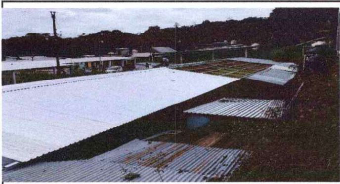
Foto 3: Sustitución de elementos de fijacion
