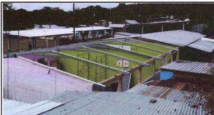
Foto 3: Sustitución de elementos de fijación
