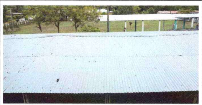
Foto 2: Sustitución de capote de lámina para lámina troquelada
