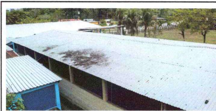
Foto 3: Sustitución de elementos de fijación
