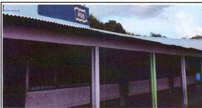
Foto 5: Reparación de bajada de agua pluvial, tubo PVC 3"
