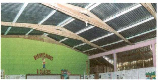
Foto 5: La madera de las aulas que seran sustituidas por estructuras metalicas.
