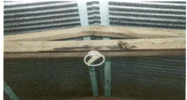
Foto 4 Techo con vista del interior que sera cambiada por estructura y que la madera esta dañada por la antigüedad
