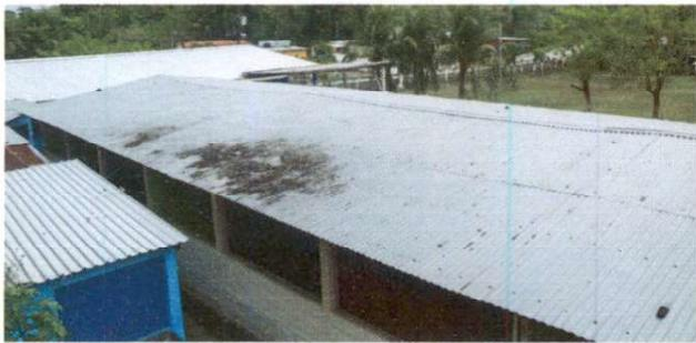
Foto 3: El techo muestra curvatura por la antigüedad que sera remozado
