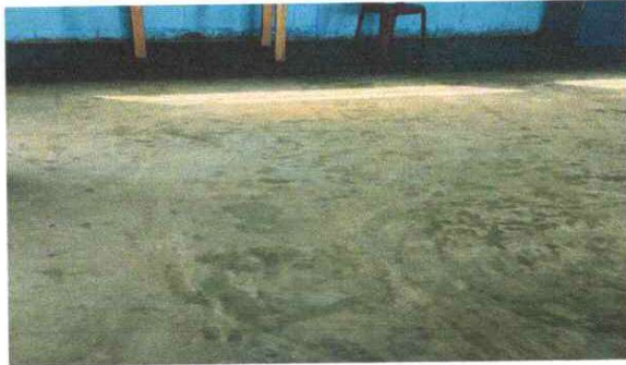
Foto1: Sustitución de piso torta por piso liquido.
