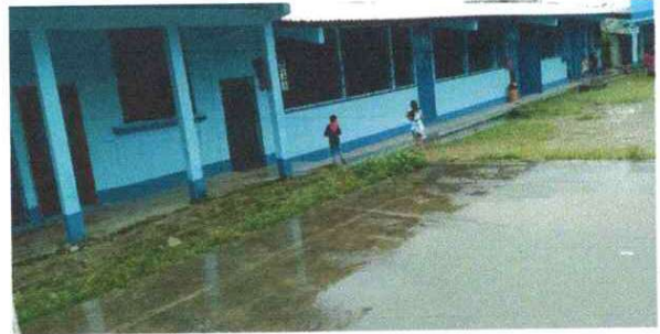
Foto 2: pintura en muros exteriores e interiores.
