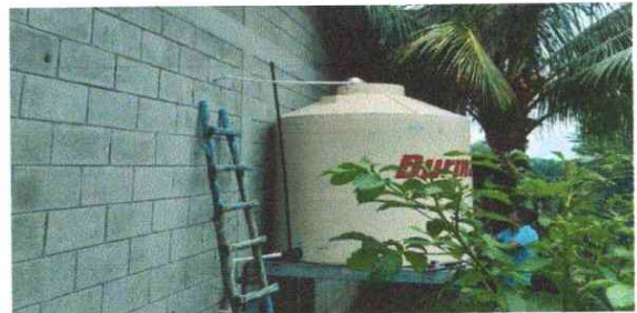
Foto 6: Instalación de rotoplas
