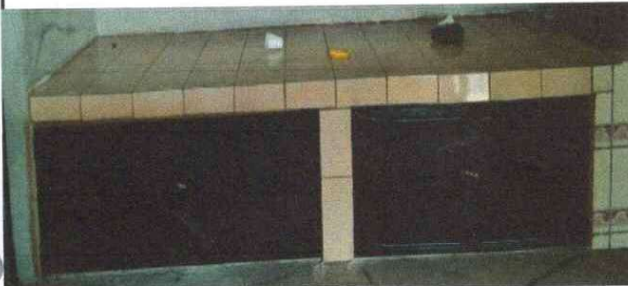
Foto 3: Instalación de azulejos en cocina
