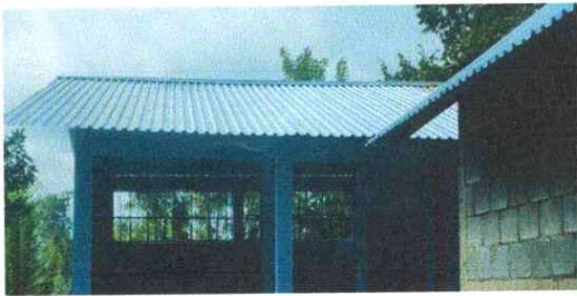
Foto 5: Instalación de lamina troquelada por lamina troquelada aluzinc calibre 26
