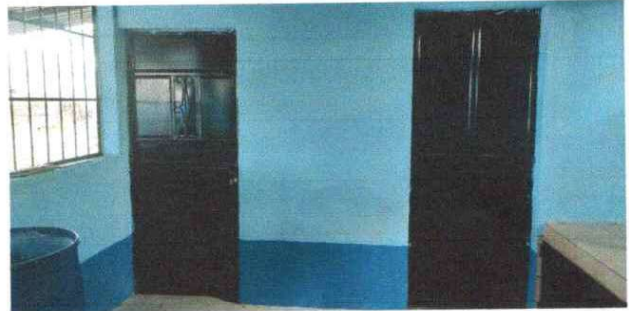
Foto 4: Sustitución de puertas
