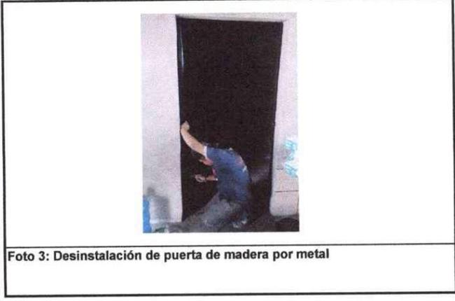
Foto 3: Desinstalación de puerta de madera por metal
