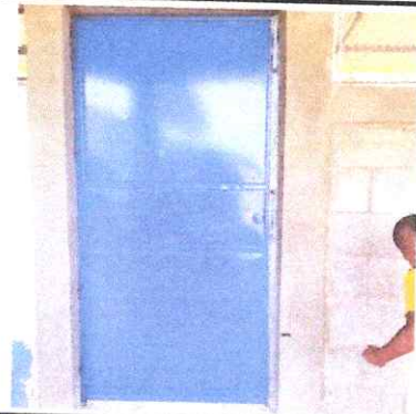
Foto 4: Instalación de puertas
