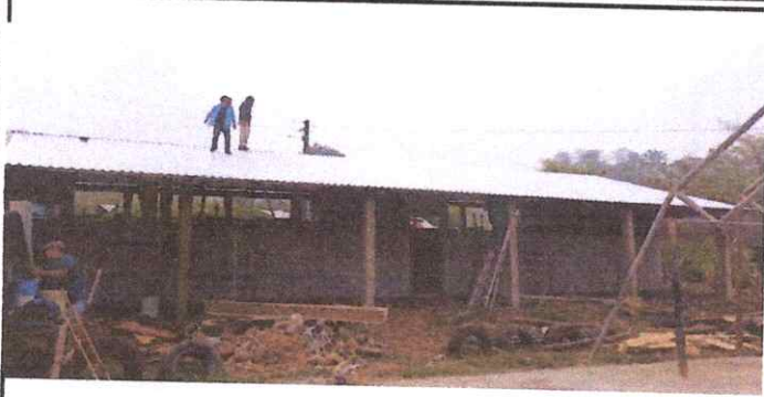
Foto 1: Entechado de las aulas
