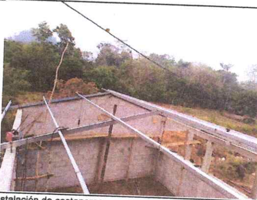
Foto 3: Instalación de costaneras.
