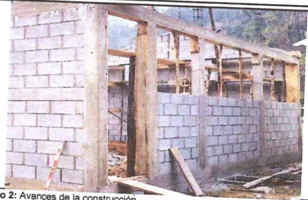
Foto 2: Avances de la construcción.
