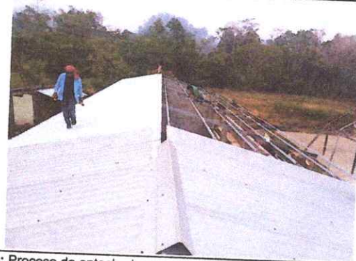
Foto 4: Proceso de entechado
