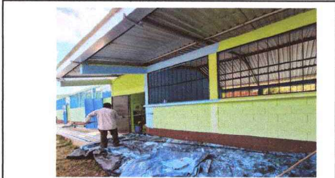
Foto1: Pintura en muros interiores y exteriores.
