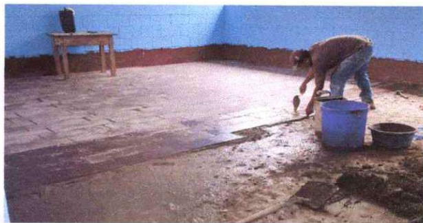
Foto 3: Reparación de piso de ceramico por piso ceramico.
