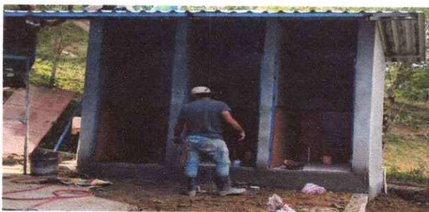
Foto 5: Sustitución de inodoros y accesorios.
