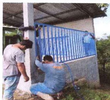
Foto 6: Sustitución de baranda de metal.
