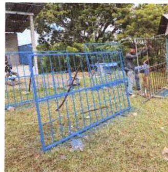
Foto 2: Mantenimiento de balcones de metal.
