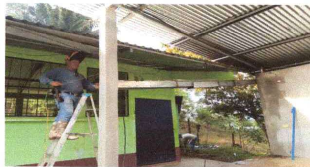
Foto 4: Sustitución de canal de metal.
