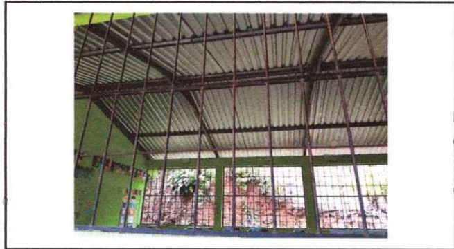
Foto 2: Mantenimiento de balcones de metal.
