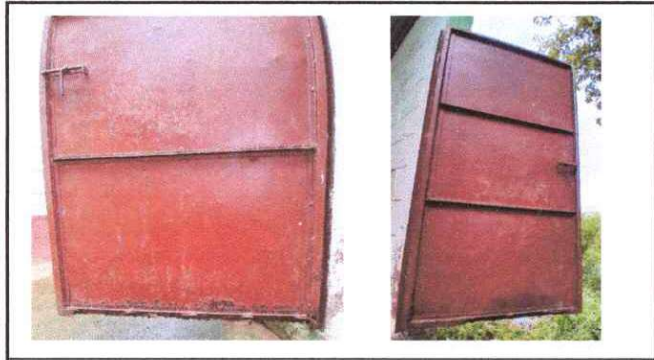
Foto1: Sustitución de puertas.
