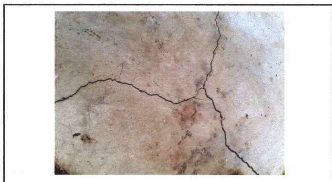
Foto 3: Reparación de piso de cemento líquido.
