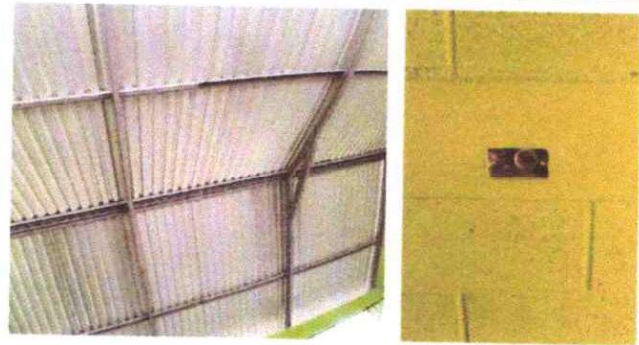
Foto 8: Sustitución de ducto electrónico + accesorios.
