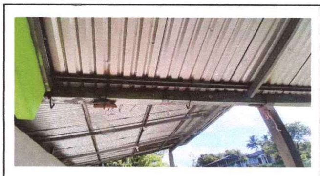
Foto 4: Sustitución de canal de metal.
