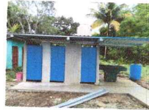
Foto 2: Fabricacion e instalación de puertas de metal en baños
