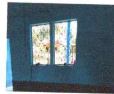
Foto 6: Sustitución de balcones de metal
