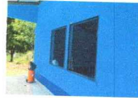
Foto 4: Sustitución de balcones de metal
