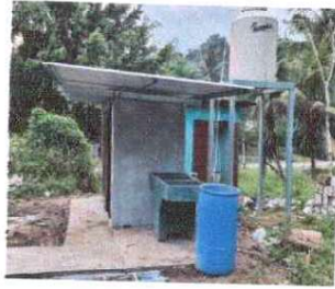
Foto 1: Sustitución de lamina
