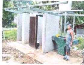
Foto 1: Sustitución de lamina
