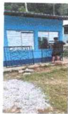
Foto 5: Sustitución de balcones de metal
