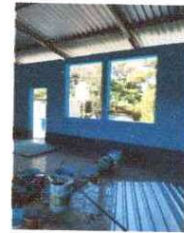
Foto 6: Sustitución de balcones de metal
