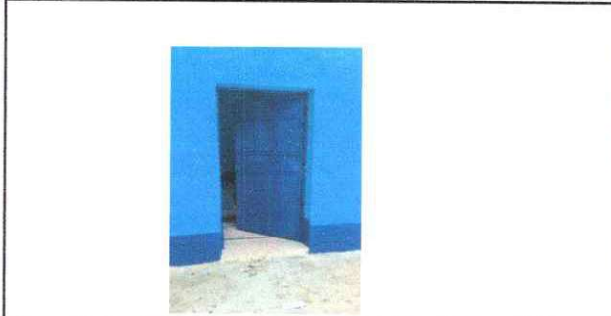
Foto 13: Mantenimiento de estructura (lijado, cepillado, sujeciones, aplicacion de pintura)
