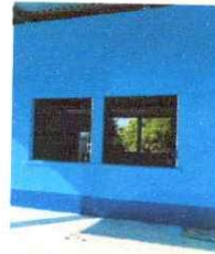
Foto 4: Sustitución de balcones de metal
