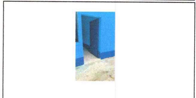
Foto 14: Mantenimiento de estructura (lijado, cepillado, sujeciones, aplicacion de pintura)
