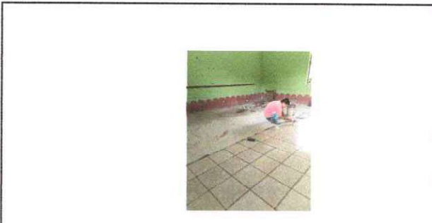
Foto 15: Sustitución de piso, ceramico
