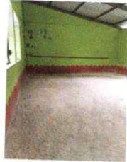
Foto 19: Sustitución de piso, ceramico
