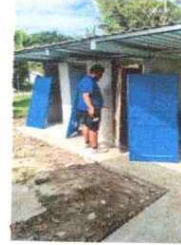
Foto 2: Fabricacion e instalacion de puertas de metal en baños
