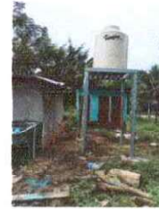
Foto 8: Sustitución de deposito de agua 1100lt
