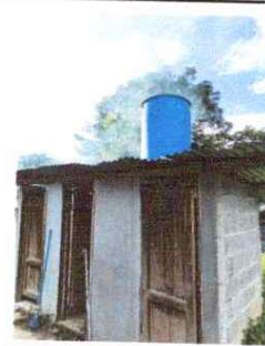
Foto 2: Fabricacion e instalación de puertas de metal en baños
