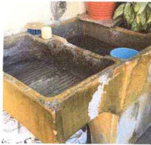
Foto 9: Sustitución de pila de cemento de dos lavaderos
