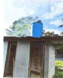
Foto 8: Sustitución de deposito de agua 1100lt
