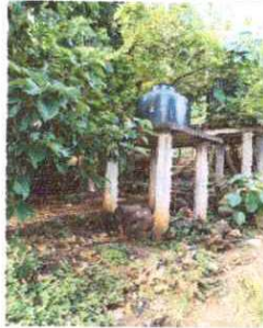
Foto 7: Sustitución de deposito de agua 1100lt
