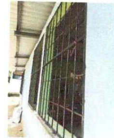
Foto 6: Sustitución de balcones de metal
