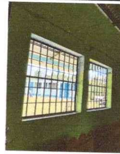
Foto 4: Sustitución de balcones de metal
