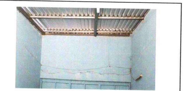
Foto 17 sellado de grietas y fisuras en muros
