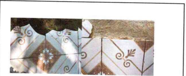
Foto 15: Sustitución de piso, ceramico
