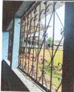
Foto 5: Sustitución de balcones de metal
