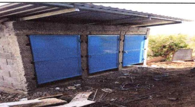
Foto 4: ESTRUCTURA DE METAL, LAMINAS Y PUERTAS INSTALADAS EN BAÑOS
