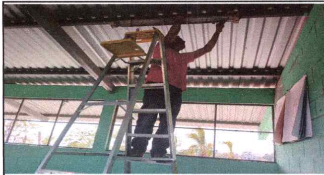
Foto 2: INSTALACION DE SISTEMA ELECTRICO
