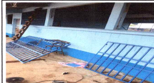
Foto 4: INSTALACION DE BALCONES
