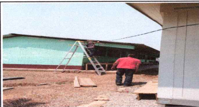
Foto1: INSTALACION DE SISTEMA ELECTRICO
