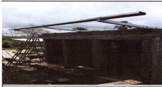
Foto 6: INSTALACION DE LAMINA Y ESTRUCTURA METALICA EN BAÑOS
