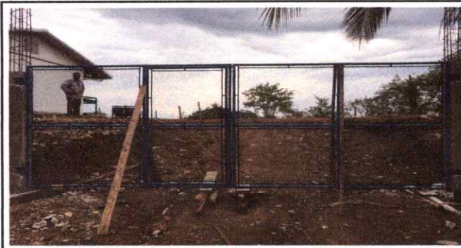
Foto 3: INSTALACION DE PORTON
