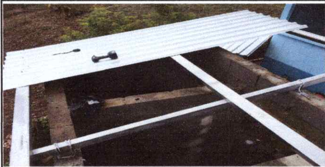
Foto1: INSTALACION DE LAMINA Y ESTRUCTURA METALICA EN BAÑOS
