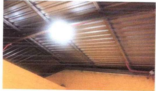
Foto 4: SUSTITUCION DE DUCTO ELECTRICO+ACCESORIO
