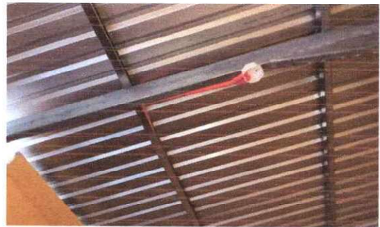
Foto 4: SUSTITUCION DE DUCTO ELECTRICO+ACCESORIO
