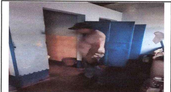
Foto 3: Reparación de puertas
