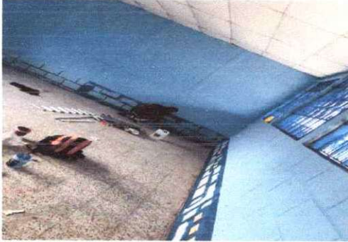
FOTO 1: SUSTITUCION DE PINTURA INTERIOR Y EXTERIOR
