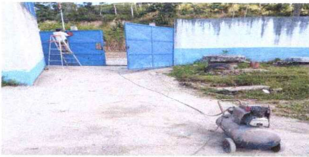
Foto 3: MANTENIMIENTO DE METAL DE INGRESO
