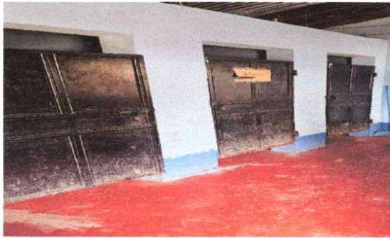
Foto 3: Reparación de puertas
