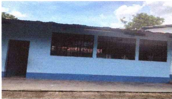
Foto 1: sustitución de lamina por lamina troquelada aluzinc calibre 26
