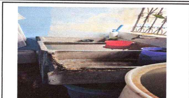
Foto 2: Sustitución de Pila
