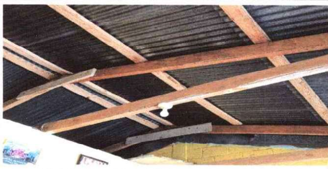
Foto 5: sustitución de Estructura de Soporte de madera por metal.
