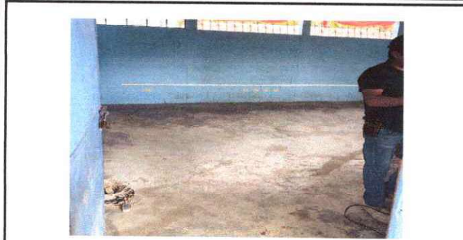
Foto 1: sustitución de pintura interior y exterior
