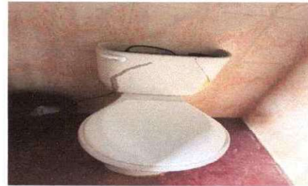
Foto 4: sustitución de inodoros
