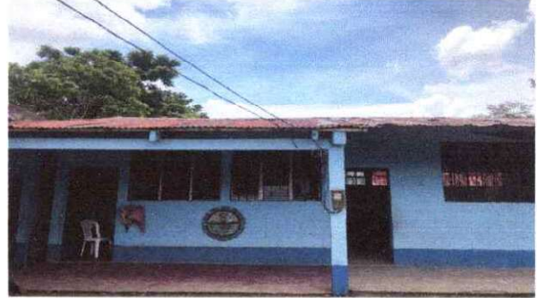
Foto 2: sustitución de lamina por lamina troquelada aluzinc calibre 26
