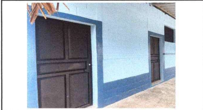
Foto1: Sustitución de puerta de metal.
