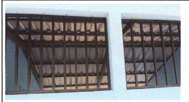
Foto 2: Sustitución de balcones de metal
