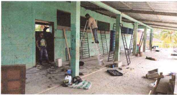
Foto 3: Sustitución de ventanas de metal.
