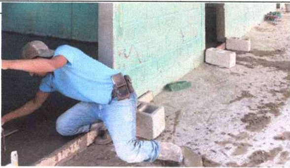
Foto: 4 Sustitución de piso líquido por piso líquido.
