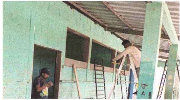
Foto 2: Sustitución de balcones de metal
