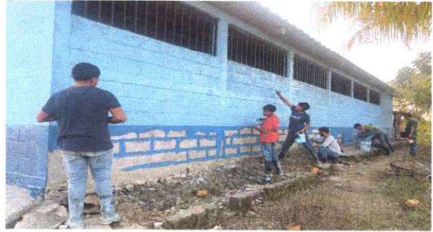
Foto 4: Pinturas en muros exteriores e interiores.
