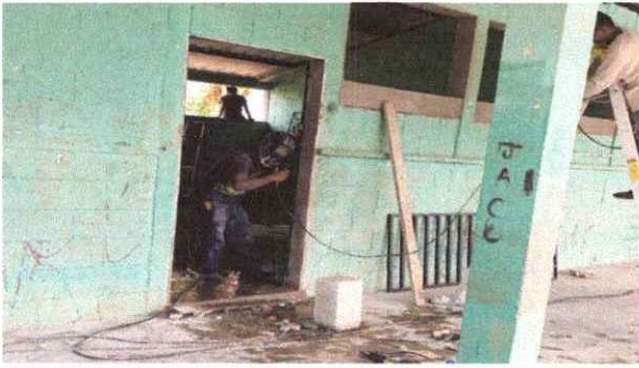
Foto1: Sustitución de puerta de metal.
