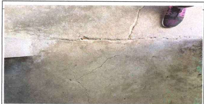
Foto: 4 Sustitución de piso liquido por piso liquido.
