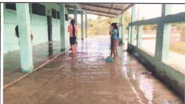
Foto 4: Pinturas en muros exteriores e interiores.
