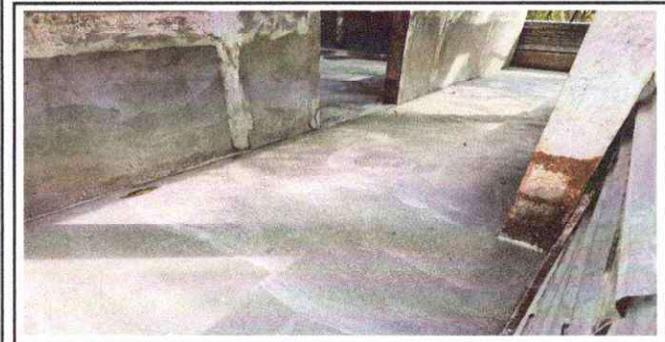
Foto 5: SUSTITUCIÓN DE BANQUETA DE CONCRETO.
