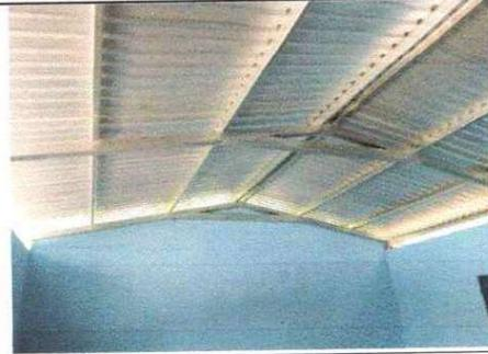
Foto 2: Sustitución de lamina por lamina troquelada aluzinc calibre 26
