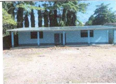
Foto 4: Sustitución de lamina por lamina troquelada aluzinc calibre 26
