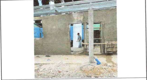
Foto 2: Sellado de grietas y fisuras en muro
