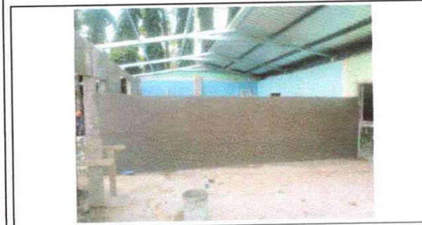
Foto 5: Sustitucion de capote de lamina para lamina troquelada
