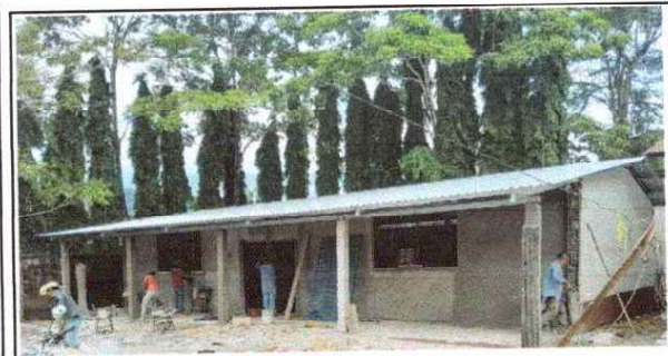
Foto 3: Pinturas en muros exteriores e interiores
