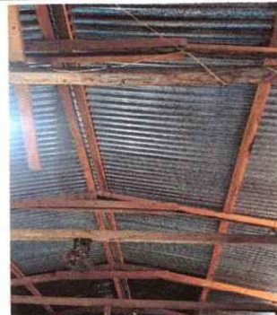
Foto 4: Sustitución de capote de lámina para lámina troquelada
