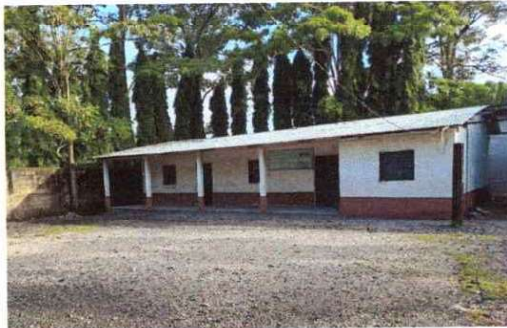
Foto 5: Pintura en muros exteriores e interiores
