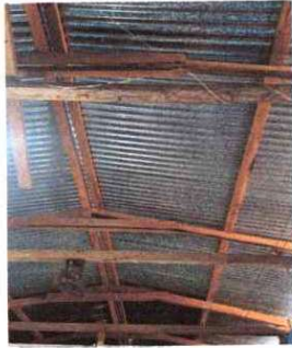
Foto1: Sustitución de lámina, por lámina troquelada aluzinc calibre 26
