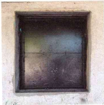
Foto 3: Sustitución de estructura de metal ventana
