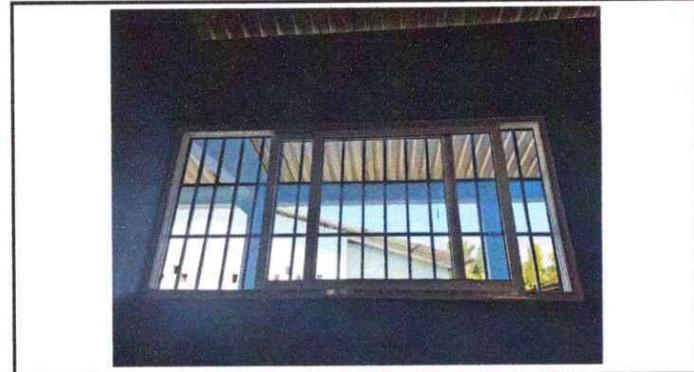
Foto 4: Fabricación e instalación de ventana-balcon de metal.
