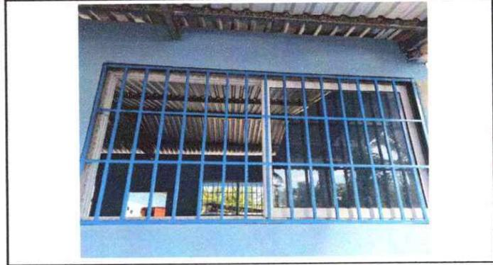
Foto 2: Fabricación e instación de balcones de hierro en ventana.
