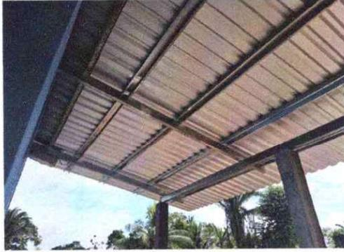
Foto 7: Sustrucción de estructura de soporte de madera por metal, instalación de lámina troquelada aluzinc. Sustrucción de focos ahorradores, plafoneras, cableado electrico, interruptores dobles.
