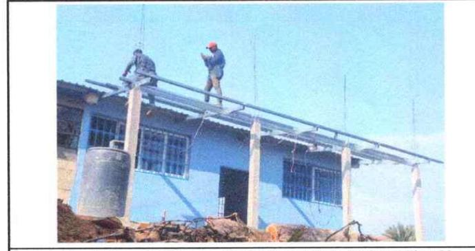
Foto 6: Sustrucción de lámina por lámina troquelada aluzinc calibre 26.
