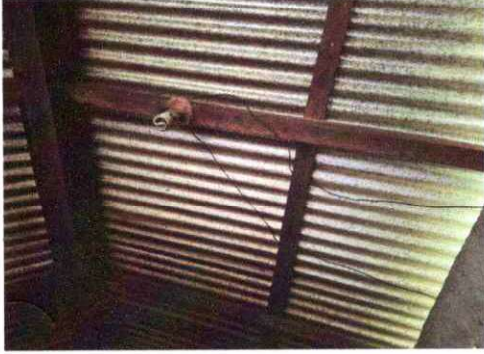
Foto 7: Sustitución de estructura de soporte de madera por metal, instalación de lámina troquelada aluzinc. Sustitución de focos ahorradores, plafoneras, cableado eléctrico, interruptores dobles.
