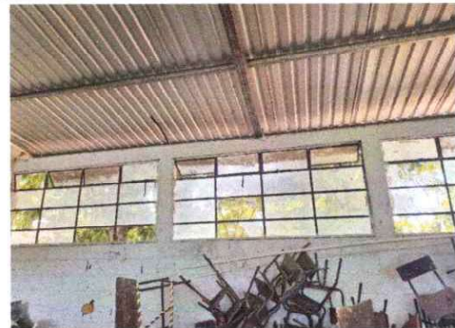
Foto 4: Fabricación e instalación de ventana-balcon de metal.
