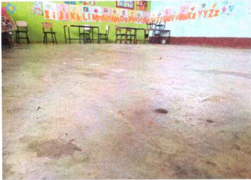
Foto1: Sustitución de piso de torta de concreto.
