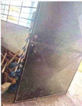
Foto 3: Sustitución de puerta.
