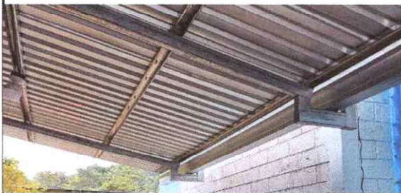
FOTO 5. INSTALACION DE CANAL
