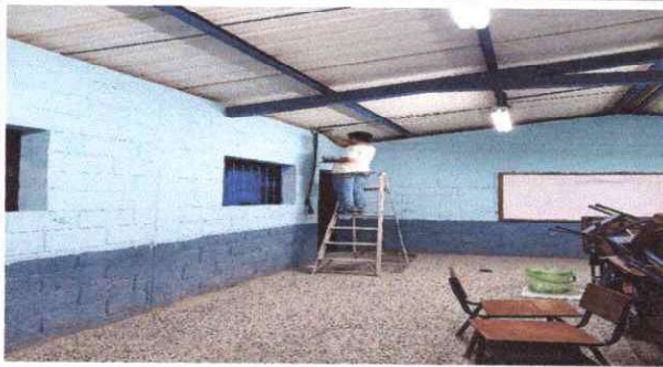
FOTO 9. PINTURA EXTERIOR E INTERIOR
