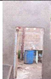
FOTO 4. SUSTITUCION DE PUERTA
