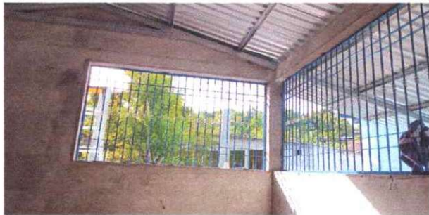
FOTO 3. INSTALACION DE BALCON
