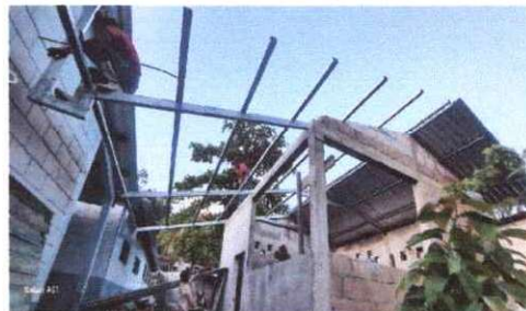
FOTO 2. INSTALACION DE LAMINA TROQUELADA ALUCINC CALIBRE 26
