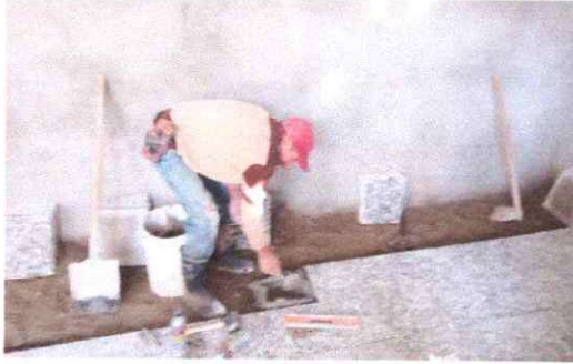
FOTO 7. SUSTITUCION DE PISO DE GRANITO
