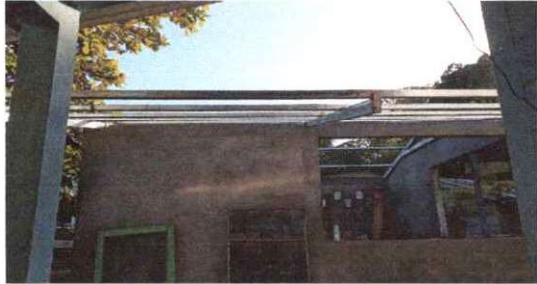
FOTO 1. INSTALACION DE ESTRUCTURA DE SOPORTE DE METAL
