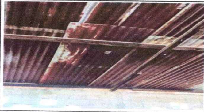
FOTO 1: CAMBIO DE LAMINA POR LAMINA DE ALUZIN.
