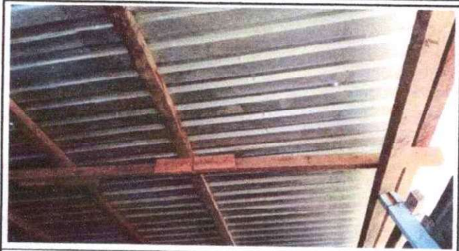
FOTO 2: ESTRUCTURA DE TECHO
