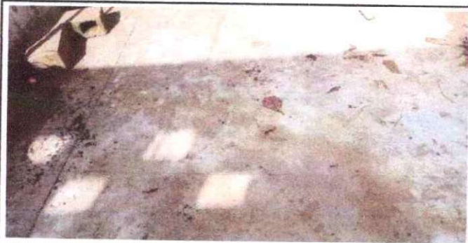
FOTO 5: SUSTITUCION DE PISO.
