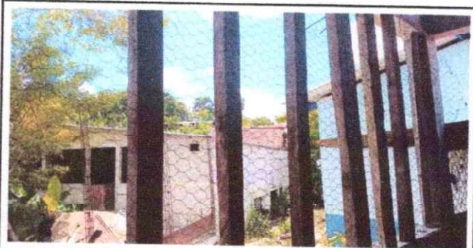
FOTO 6: SUSTITUCION DE BALCON
