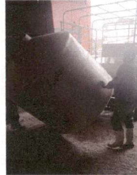
Foto 2: INSTALACION DE ROTOPLAZ DE 2500 LTS
