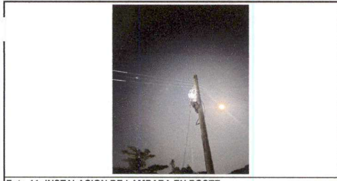
Foto 11: INSTALACION DE LAMPARA EN POSTE
