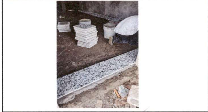
Foto 8: INSTALACION DE PISO DE GRANITO
