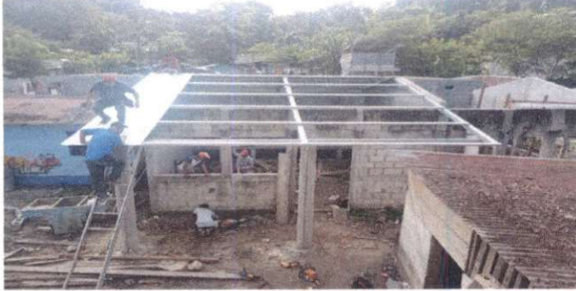
FOTO 1: SUSTITUCIÓN DE LAMINA, POR LAMINA TROQUELADA ALUZIN ALIBRE26
