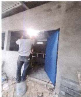
FOTO 3: INSTALACIÓN DE PUERTA DE METAL
