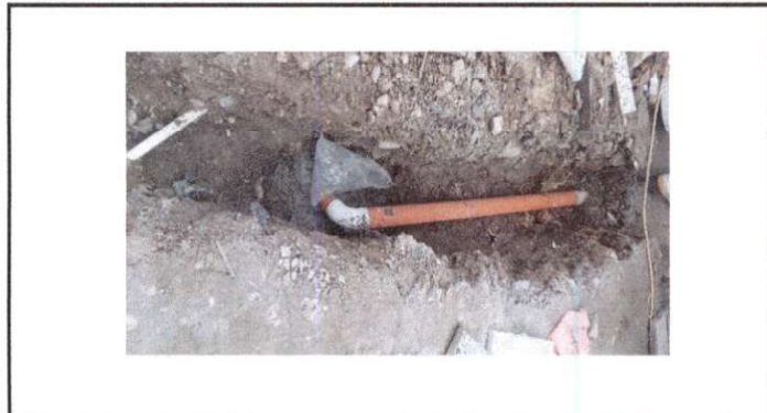
Foto 9: INSTALACION DE TUBERIA PRINCIPAL PVC PARA PILETA
