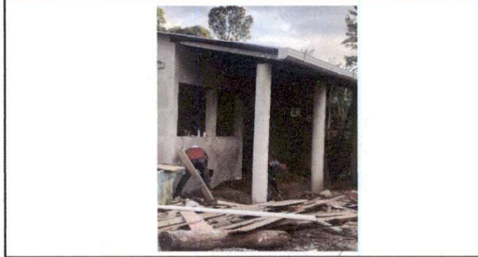
Foto 7: FABRICACION DE COLUMNAS Y TECHO
