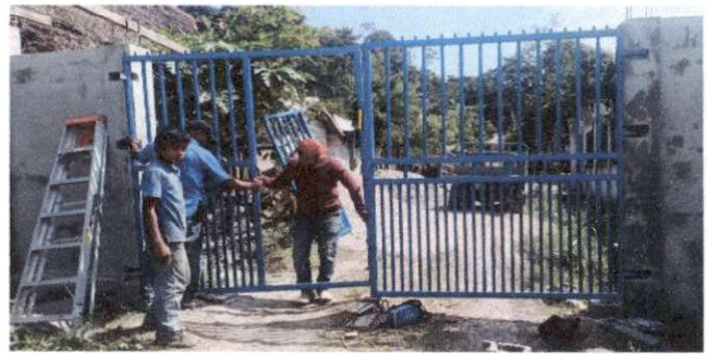
FOTO 6: INSTALACIÓN DE PORTÓN DE METAL
