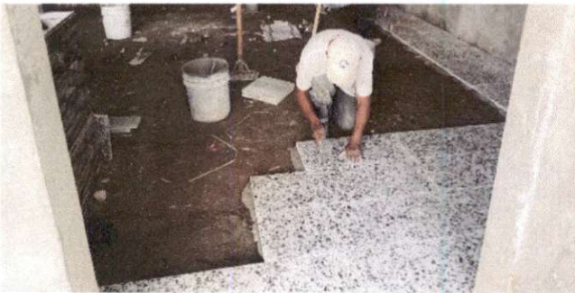
FOTO 5: SUSTITUCIÓN DE PISO DE GRANITO
