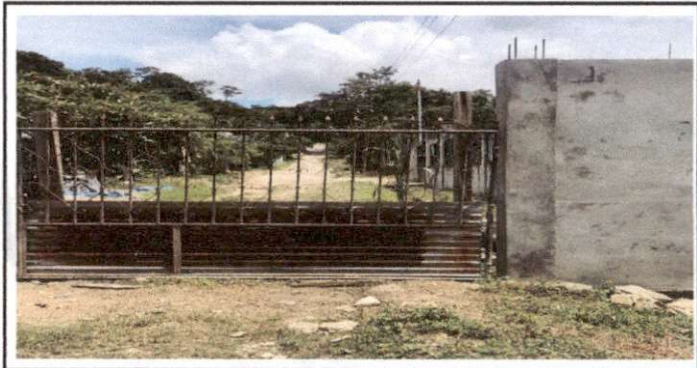
FOTO 6: SUSTITUCION DE PORTON.
