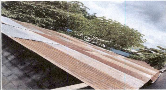
FOTO 1: CAMBIO DE LAMINA POR LAMINA DE ALUZIN.
