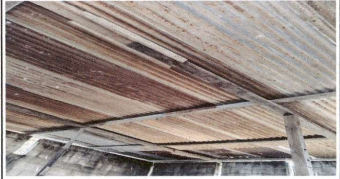
FOTO 2: ESTRUCTURA DE TECHO
