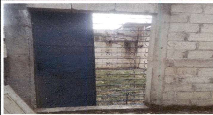
FOTO 3: CAMBIO DE PUERTA PRINCIPAL.
